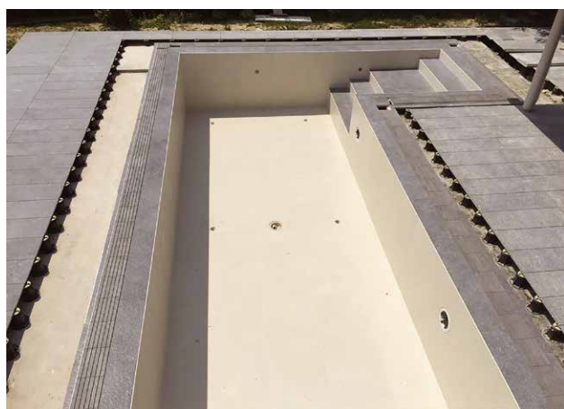
DETTAGLIO ESEMPLIFICATIVO DI PAVIMENTO SOPRAELEVATO ACCOPPIATO A BORDO VASCA A SFIORO / EXAMPLE OF FLORIM 20 MM RAISED FLOOR COUPLED WITH INFINITY POOL EDGE
